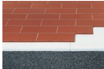
Estrichziegel auf EPS 035 DEO M 200 kPa und TONALITY-Trockenschüttung.
