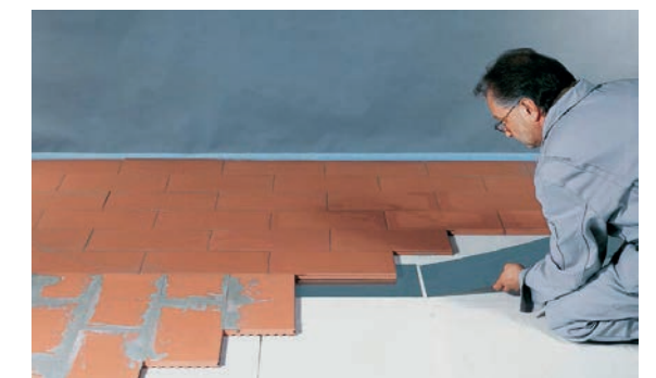
Wechsel des Verlegebildes
