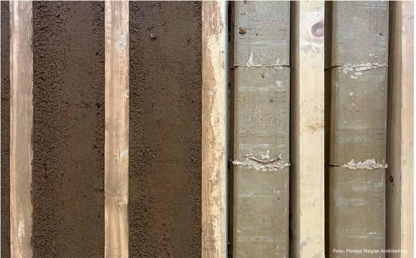
**Als konkrete Lösung für nachhaltige Architektur entstand unser Lehm-Decken-Einhängeziegel. Zwischen Holzbalken platziert und mit Lehmmörtel verfüllt, bietet er Brandschutz, Schallschutz, thermische Masse und Feuchteregulierung.**
